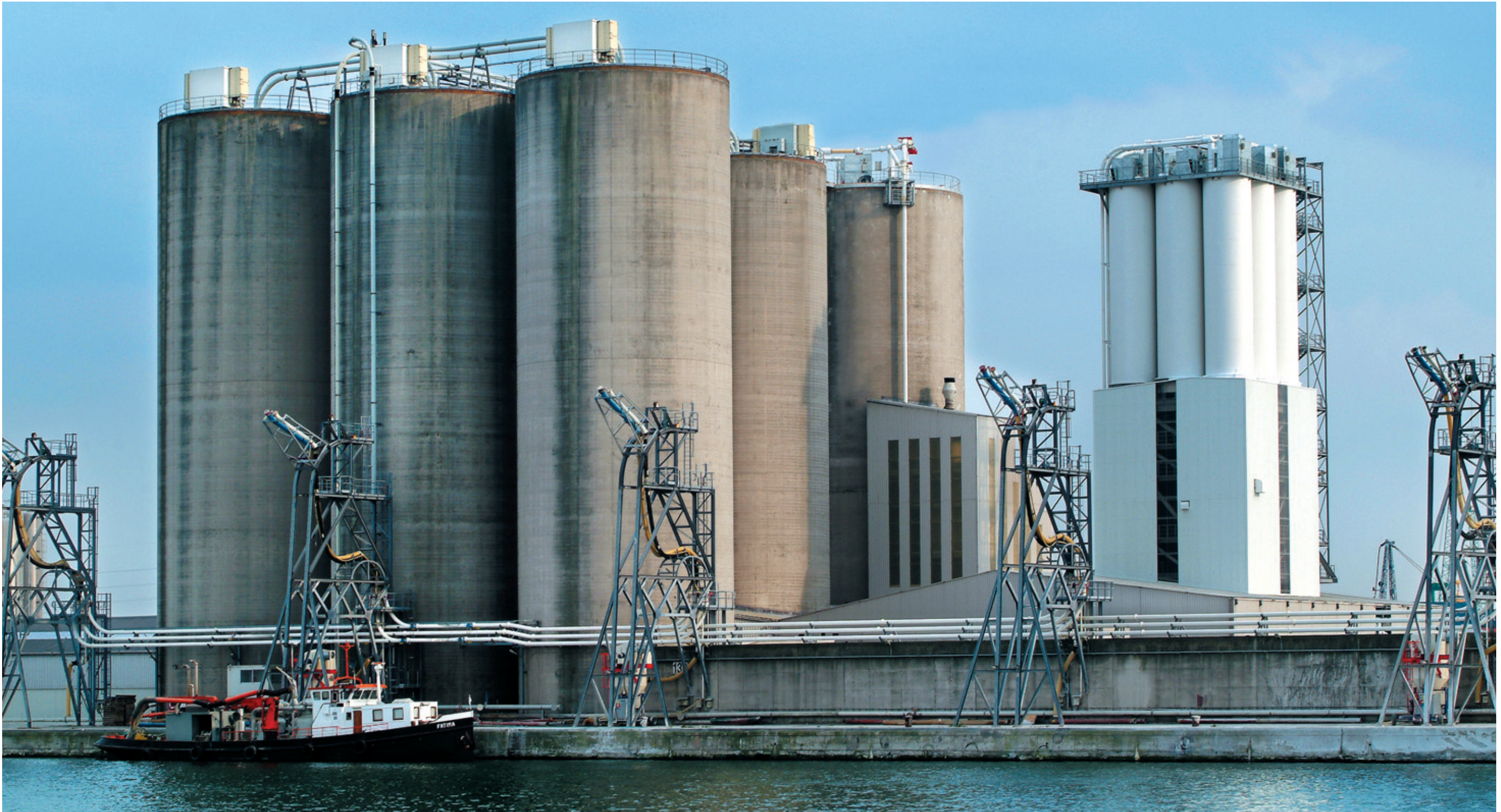
Chargen-Mischanlage, HOLCIM, Antwerpen, Belgien
