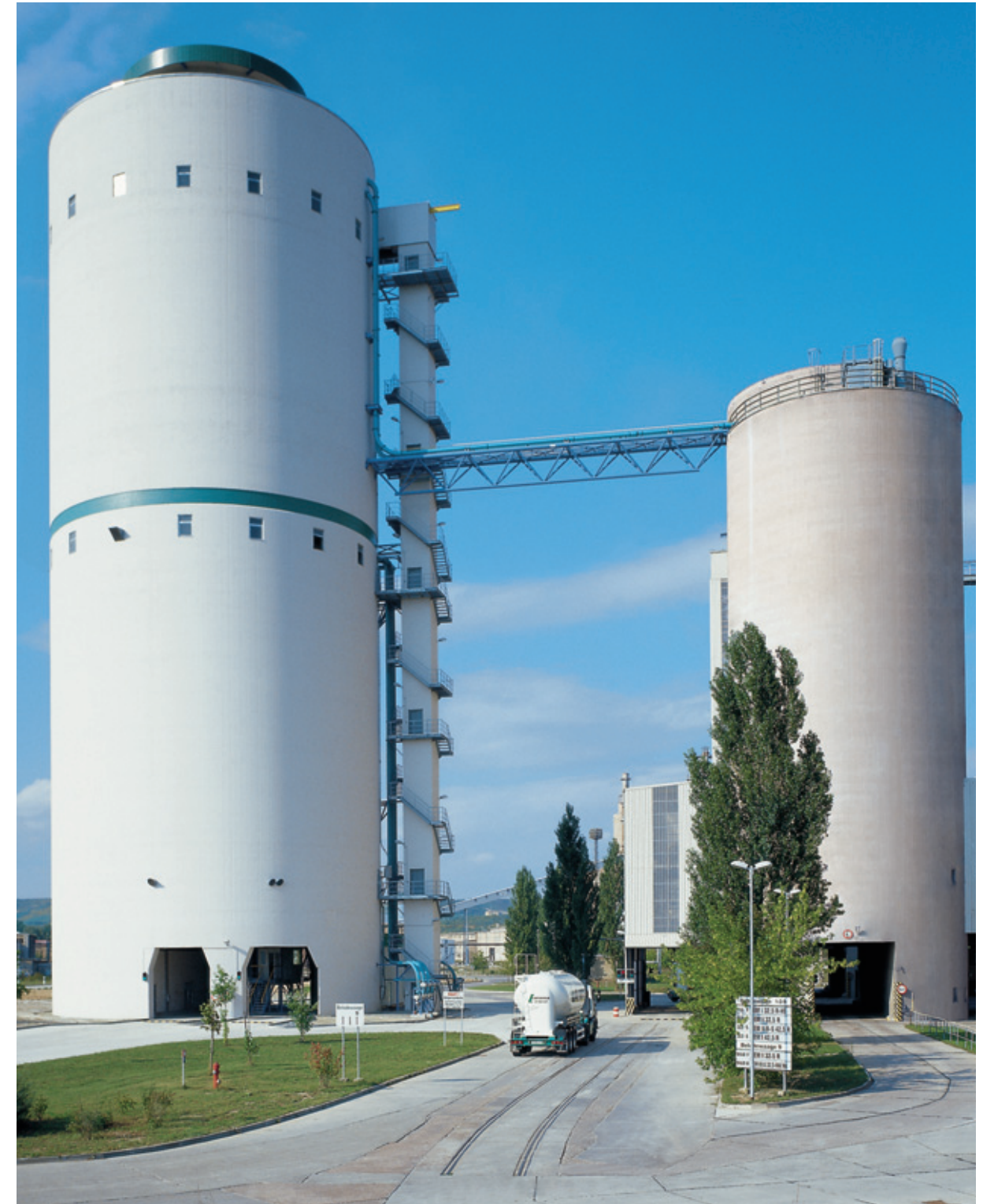
Mehrkammersiloplanlage mit integriertem Chargen-Mischsystem, LAFARGE ZEMENT, Karsdorf, Deutschland
