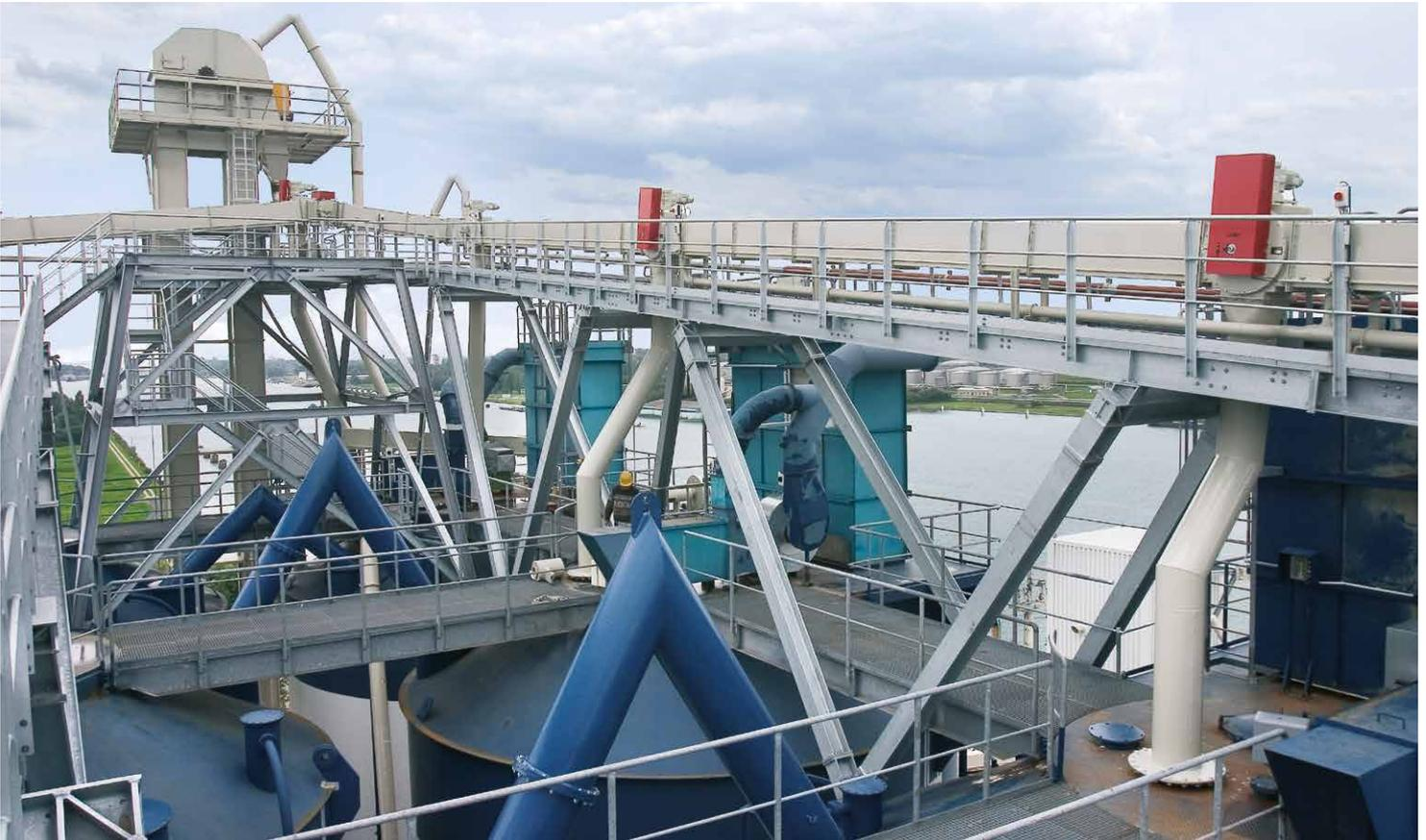
Bodenentleerer zur Beschickung verschiedener Silos eines Zementterminals.
